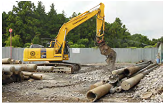
重機により破砕される電柱
