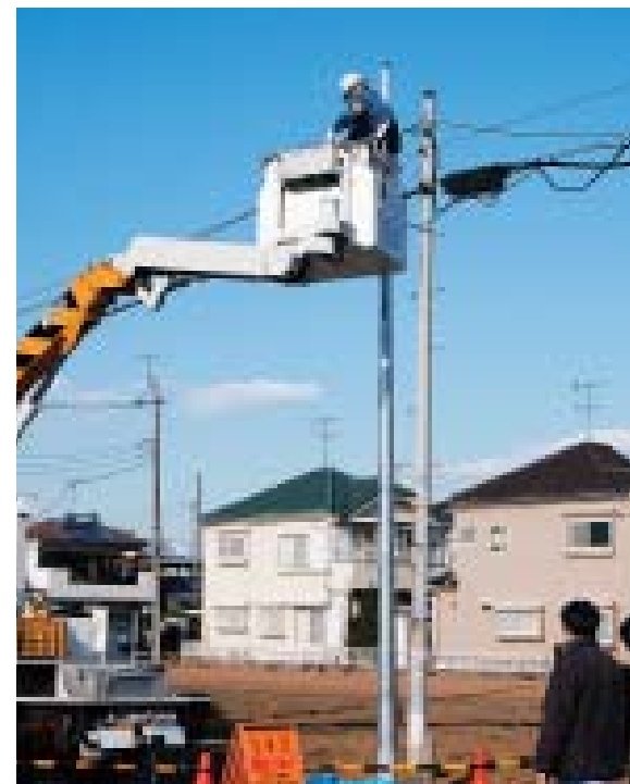
エコ鋼管柱の設置
