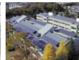
太陽光発電システム
