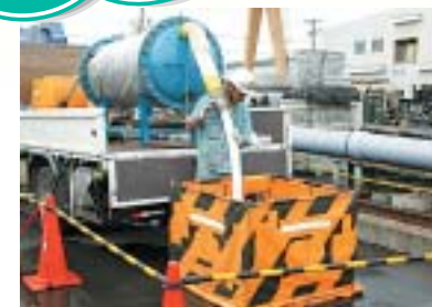
地面を掘らない地下管路の補修工事
