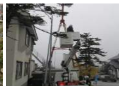
立入り禁止禁止区域内での高所作業
