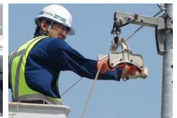
応急復旧ケーブルの布設作業
