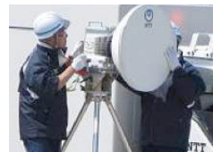
無線機の設営作業
