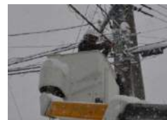
雪が降る中での電話回線、光ケーブルの敷設作業
