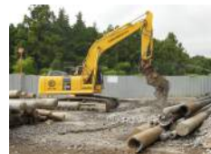
重機により破砕される電柱
