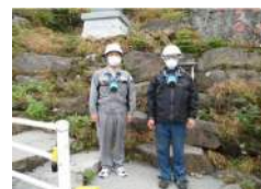
作業員は防毒マスク等を着用
