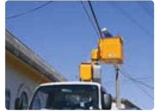
災害後の通信ケーブルの応急復旧作業
