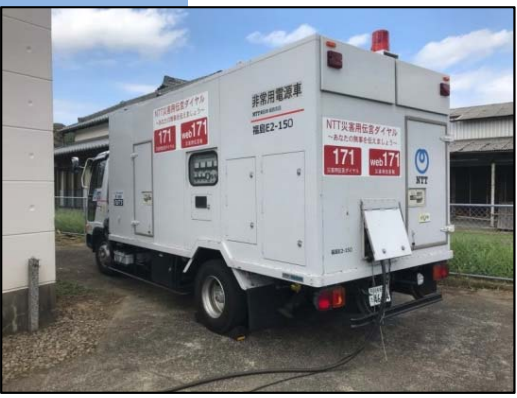
移動電源車による通信ビル機能の維持
