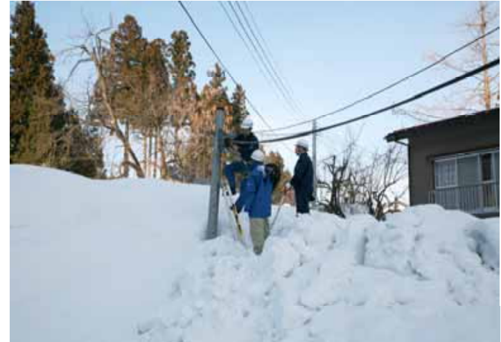
大雪の中、復旧のためケーブルを張り替える
