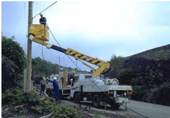
地震で被災した電柱・ケーブルの復旧を行う
