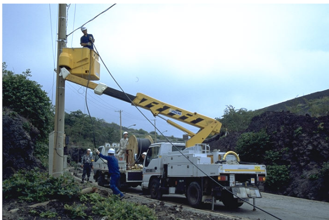
■地震で被災した電柱・ケーブルの復旧を行う
