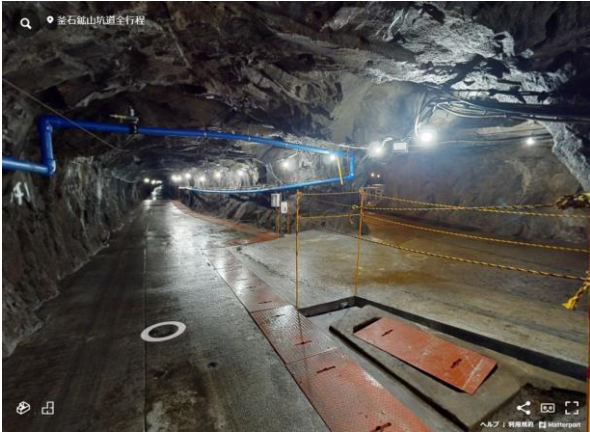
釜石鉱山 550m 坑
