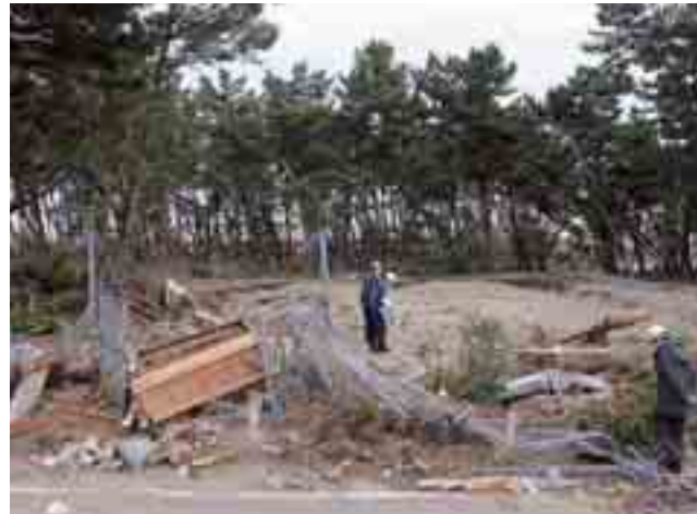
建物ごと流出した七ヶ浜ビルの跡地
