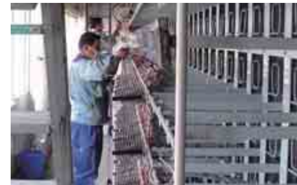
端子盤の砂を払い、一本一本線をつなぐ
