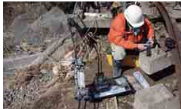
既設ケーブルと迂回ケーブルの心線接続
