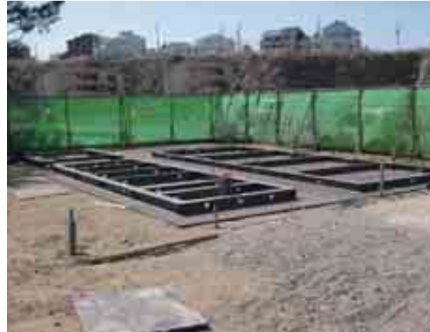
通信ビル跡地を整地し、基礎台を設置
