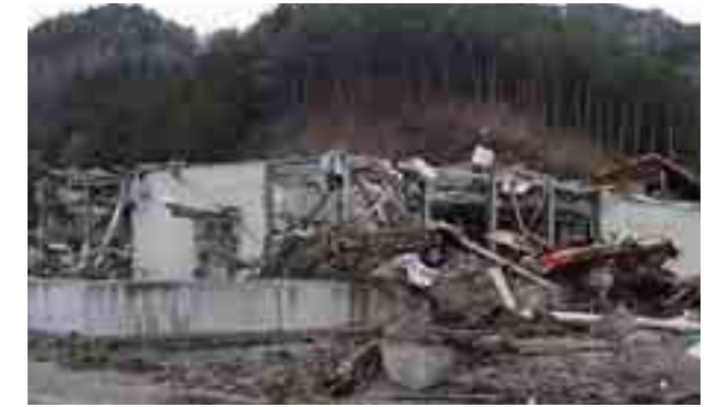
建物内外が大きく損壊
