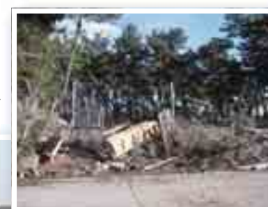
約500m流された七ヶ浜ビル 右は跡地 (宮城県七ヶ浜町)
