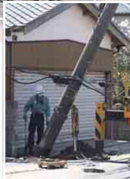
液状化によって傾倒した電柱 (茨城県潮来市)
