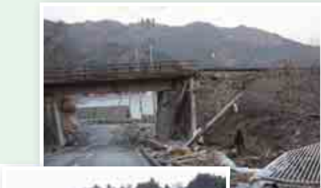
国道45号の気仙大橋が流出。橋の下に設置されていた中継伝送路も一緒に流出・切断 (岩手県陸前高田市)
