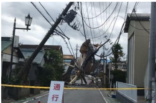
台風15号の被害
