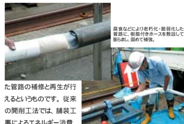
た管路の補修と再生が行えるというものです。従来の開削工法では、舗装工事によるエネルギー消費、廃棄物の増加、発生土の増加、周辺への騒音・振動、工事起因した交通渋滞によるCO<sub>2</sub>排出量の増加など、あらゆる環境負荷が問題となっていました。それらを大きく軽減できる上、コストの面でも大幅な削減が可能になりました。
