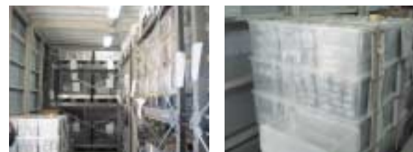
PCB保管倉庫
