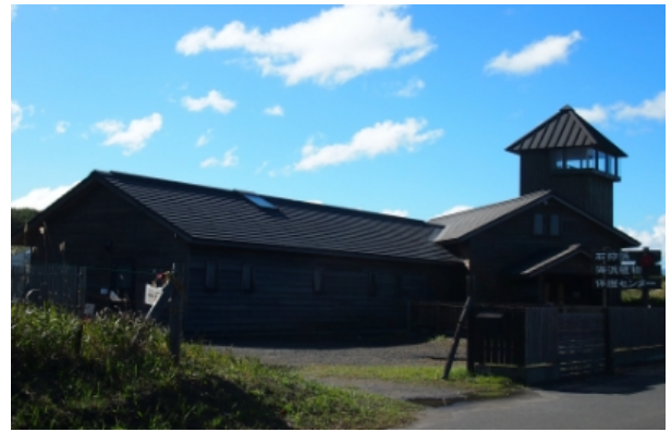
石狩浜海浜植物保護センター
