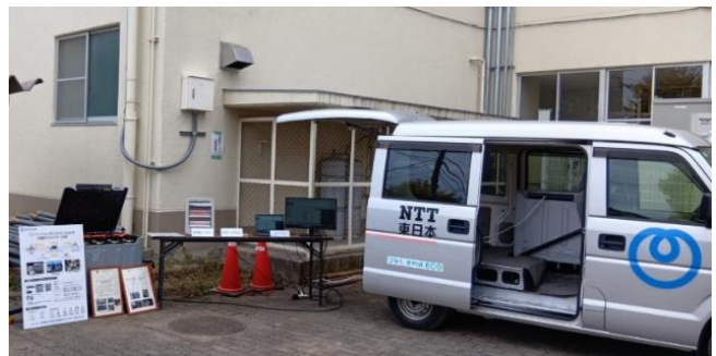
NTT 東日本社用車の CEV に搭載した可搬型バッテリーから機器類に電力を供給するデモの様子
