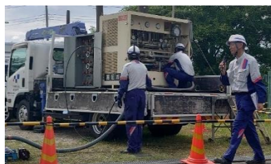
▲ガス臨時供給訓練
