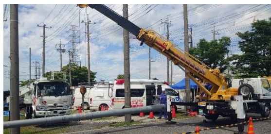
▲倒壊した電柱の除去訓練
