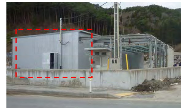
【STEP3】防塵・防風雨性の高い外壁に修繕
