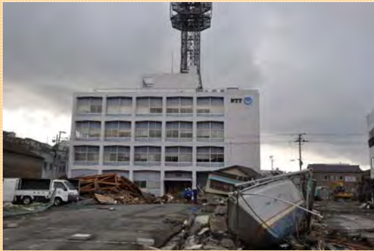
津波により浸水した門脇ビル
