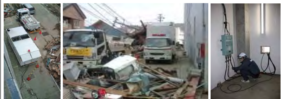
【STEP3】移動電源車を配備し接続
