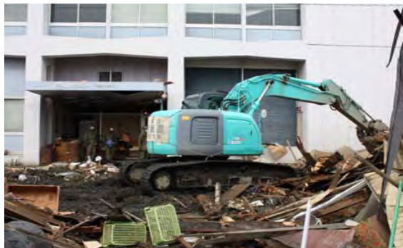
【STEP1】ビル内外の泥・瓦礫等の掻き出し
