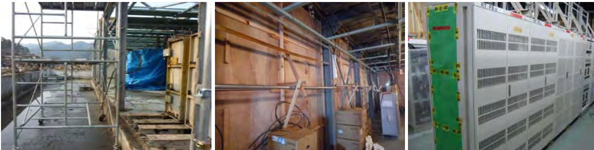
【STEP2】外壁等をビニールシート・ベニヤ板で応急復旧し、建物内に新たに電力設備・通信設備を設置
