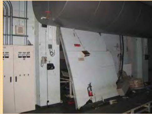
電力設備(1F)が大きく損傷
