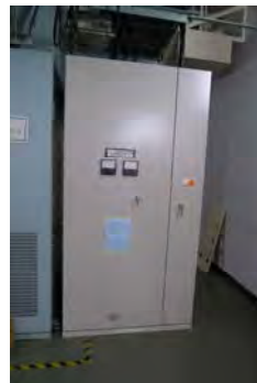
【STEP2】受電設備を3Fに新設
