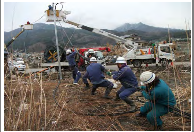
【STEP2】 架空ケーブル敷設
