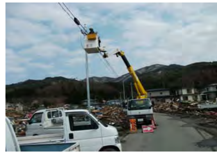
【STEP4】 架空ケーブル接続
