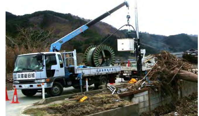
【STEP2】 架空ケーブル敷設
