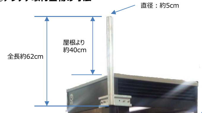
①アンテナ取付金物の寸法
