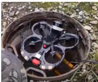
マンホールから進入する ELIOS 3
