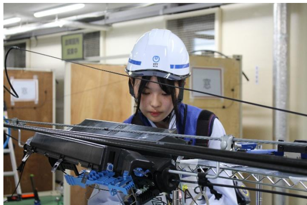
引込線設備を用いた作業の様子（過去開催）
