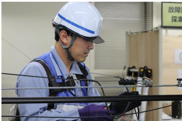
故障箇所を特定し、復旧作業を行う様子（過去開催）
