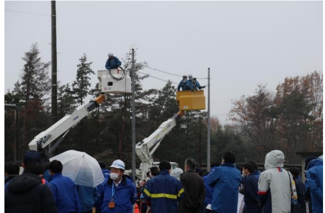
建柱および通線による通信設備の復旧
