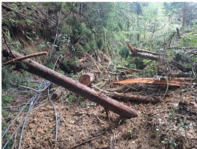
土砂崩れ、倒木により通信設備が被災している様子
