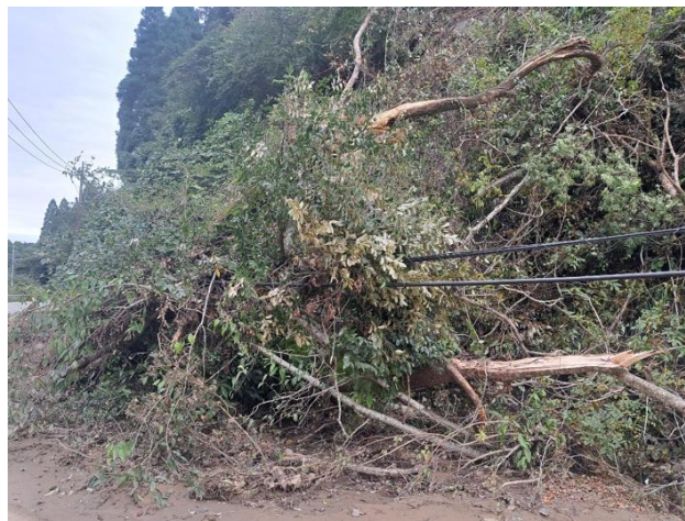
土砂崩れ、倒木により通信設備が被災している様子
