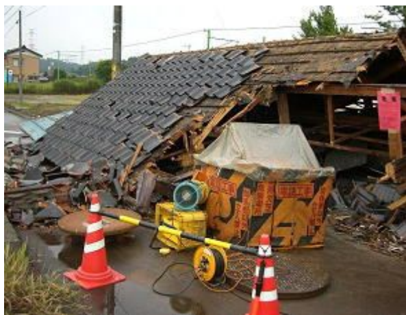
[新潟中越沖地震(マンホールの上に家屋が倒壊)]
