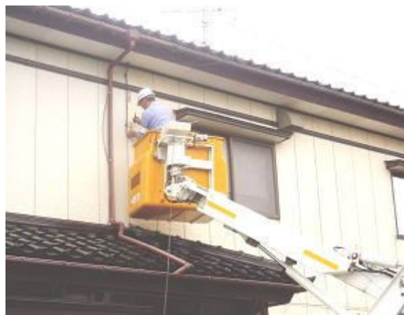
[新潟中越沖地震(引込線・保安器の取替え作業)]
