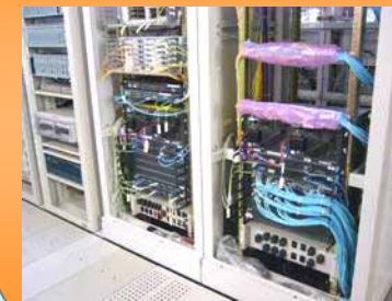
他社のIP系設備の例 【ルータ・SW】
