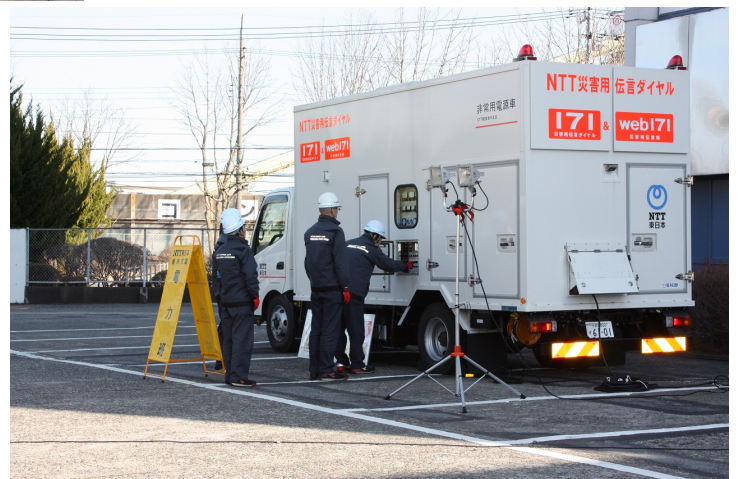
④ 移動電源車による新型ポータブル衛星機器への給電訓練
