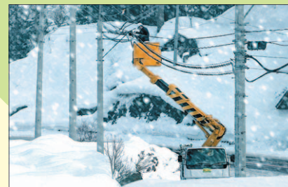
雪の中の作業
