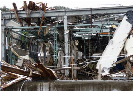
«Unosumai Building, Iwate Pref.»
