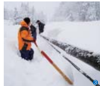
写真③ ケーブルの掘り出し作業
