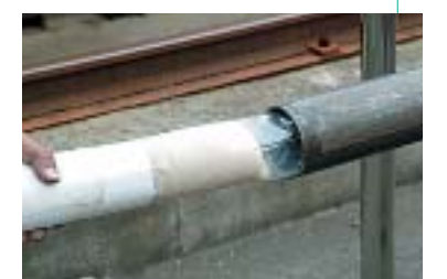
腐食などにより老朽化・脆弱化した管路に、樹脂付きホースを敷設して膨らませ、固めて補強
