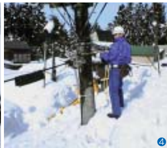
写真④ 加入者宅での引込線の故障修理
