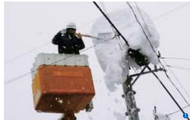
写真① 通信線路のケーブル芯線を鋼管柱の上で相互接続する「端子箱」に積もった雪の、雪落とし作業。道路除雪のロータリー車から跳ね上げられた雪により、端子箱が破損して重大な障害が発生することもある。そのため作業員自身が着ている防水性の高い作業用ジャケットを脱いで、応急措置としてむき出しのケーブル芯線に巻きつけることもある。
