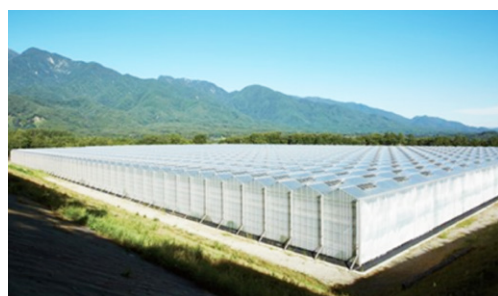
次世代施設園芸の外観イメージ
