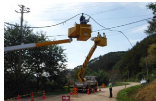
通信障害の応急復旧作業
