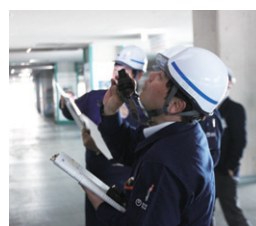
競技場における点検作業風景
