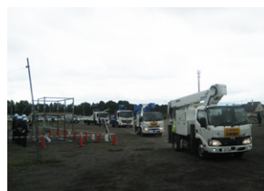
作業車両入場
