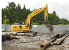
重機により破砕される電柱
