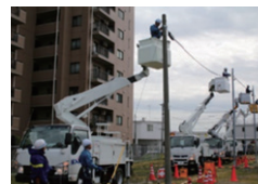
通信ケーブルを修理する訓練
