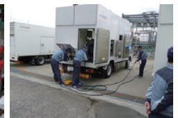
ケーブル敷設
