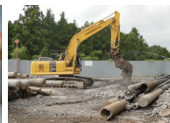
重機により破碎される電柱
