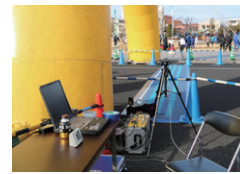
計測地点に設置した計測システム
