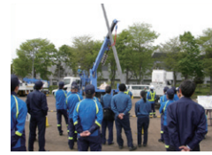
通信ケーブルの復旧(建柱作業)
