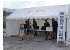
通信施設復旧作業
