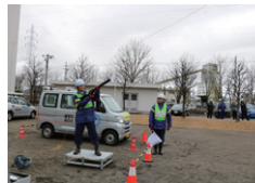
対岸等に仮装ケーブルを敷設する際に使用するロケットランチャー
