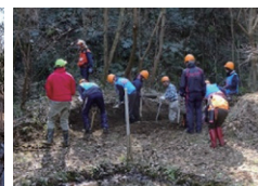
土砂で埋まった水路の修復
