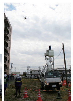
マルチヘリを用いた通信ケーブル敷設訓練
