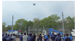
通信ケーブルの復旧(ドローンによる通線)
