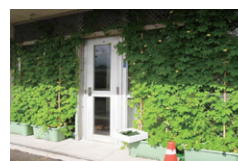
東京事業部 八丈島ビル
