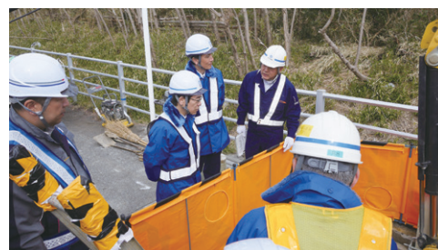
競技会場への地下管路構築工事の様子
