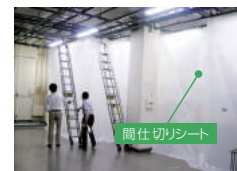
簡易間仕切り設置状況 (設備撤去スペース)
