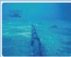
水底ケーブル 800km
