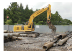
重機により破砕される電柱
