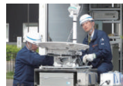
無線機の設置作業
