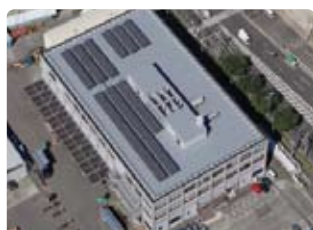
太陽光発電設備を導入した東日本ロジスティックセンタ
