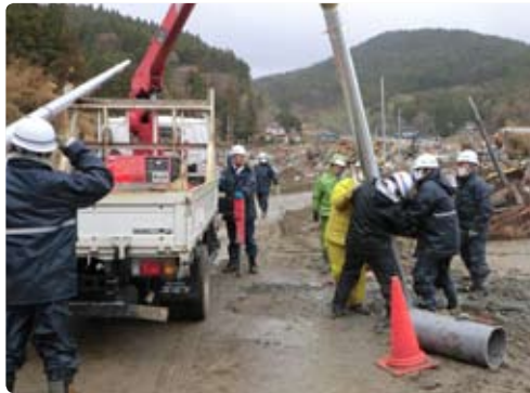
電柱の復旧模様
