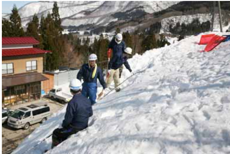
雪の重みでケーブルが切れないよう除雪作業を行う
