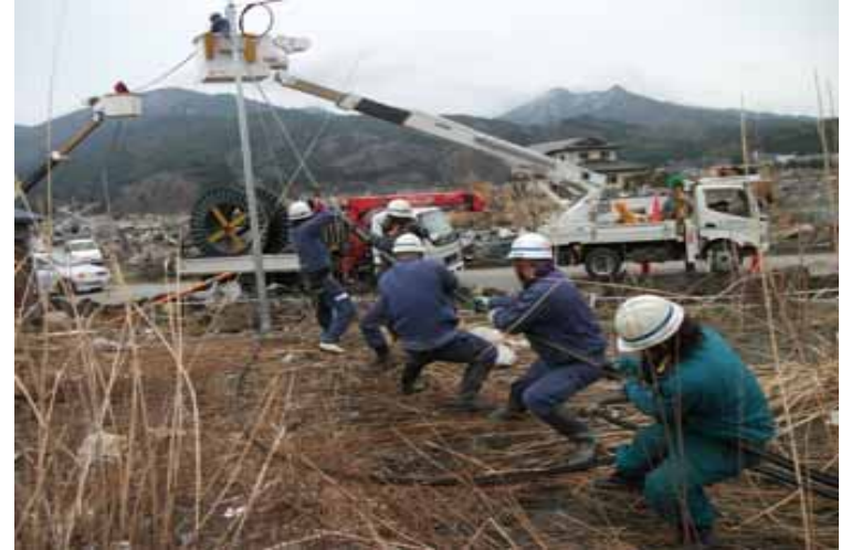
被災した電柱・ケーブルの復旧を行う
