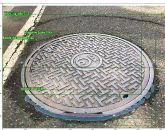
【左】AI 検知サンプル画像(ヒビ割れなど AI 検知結果を画像へ付与)
