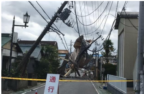
台風15号の被害
