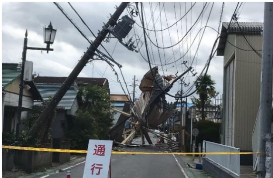
台風15号の被害
