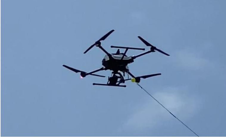
リード線を対岸へ運搬する通線ドローン
